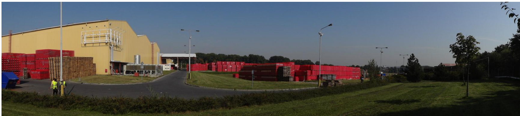
Obr. 5 Prostor výstavby, pohled na stávající areál Coca-Cola HBC Česká republika, s.r.o., ve směru západ – východ, výrobní hala a skladování plastových přepravek
