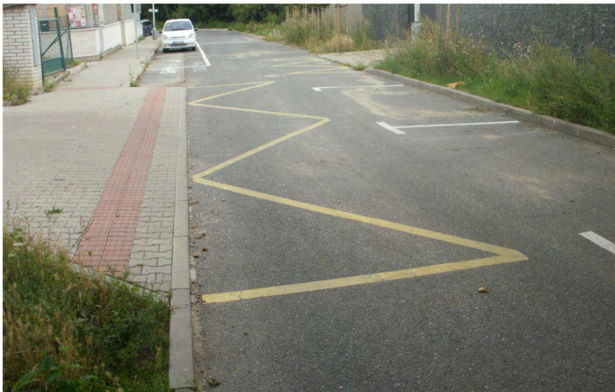
Obrázek 11: Nevhodně provedený varovný pás u výjezdu z parkoviště na ulici Šimanovské
