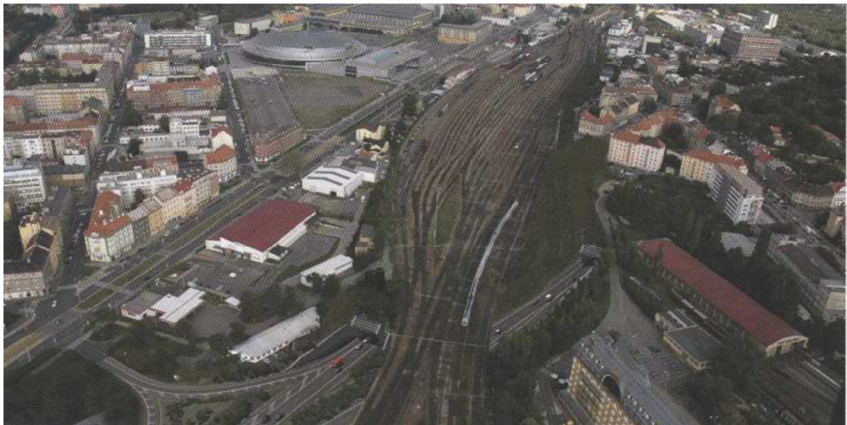
MO SE SEVERNÍM PORTÁLEM TUNELU JAROV
