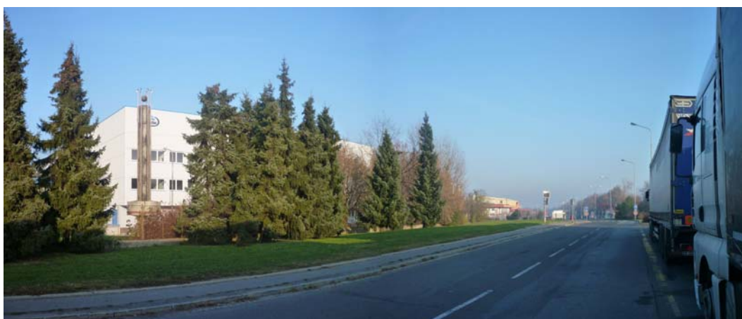
Obr. 3.3.11-12 : Průmyslový areál má kompaktní strukturu výrobních a skladovacích objektů a venkovních zpevněných ploch včetně vzrostlé zeleně ve starší části areálu (foto ATELIER V)
