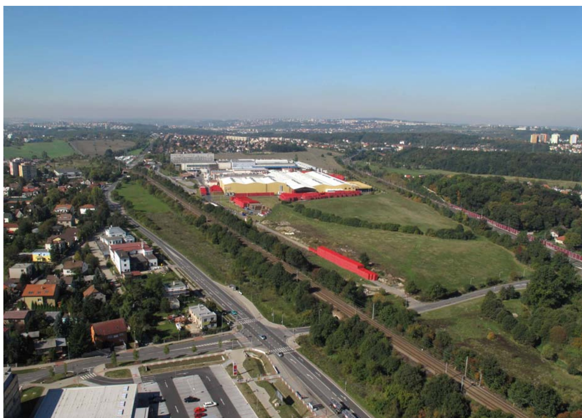
Obr. 3.3.11-12 : Areál navrhované stavby je výběžkem Malešicko – Kyjské průmyslové zóny vůči nízkopodlažní zástavbě Kyjí a Dolních Počernic (foto objednatel).
